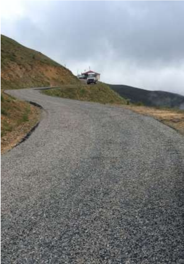
Merkez Olucak Mahalle Yolu Asfalt Çalışması
