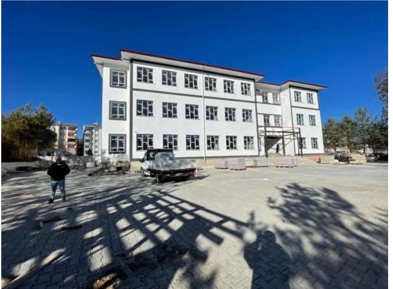
Şiran Mithatpaşa İlkokulu İnşaatı Çalışmaları
