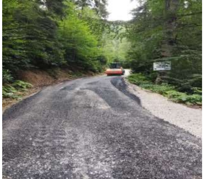
Kürtün Güvende Grup Yolu Asfalt Yama Çalışması
