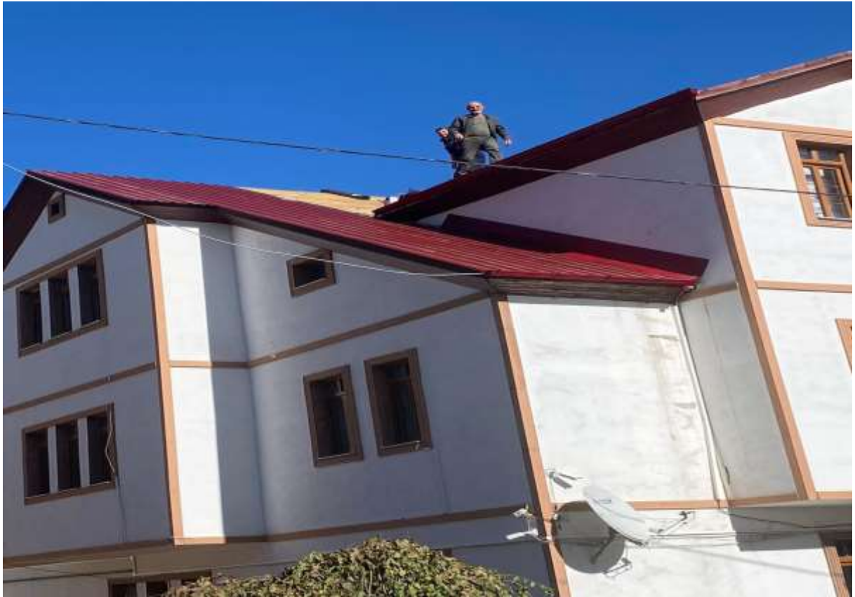
Şiran İlçesi Şehit Muhammet Fazlı Demir Anaokulu Çatı Yenileme İşi Çalışmaları
