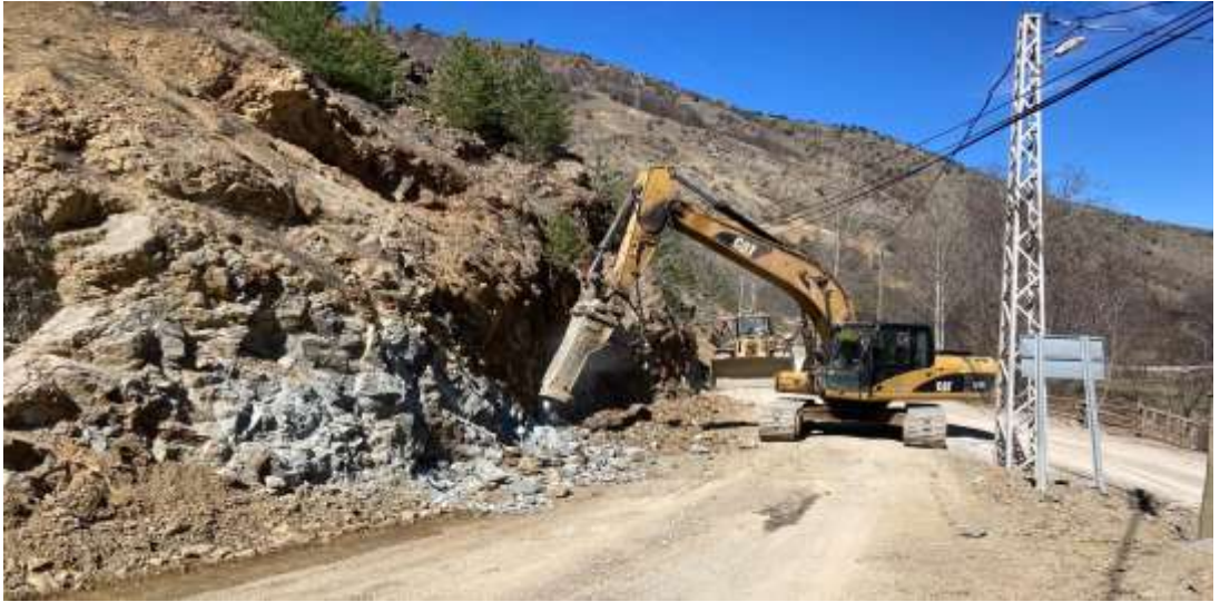
Torul-Yıldız-Gümüştüğ Grup Yolu Onarım Çalışması
