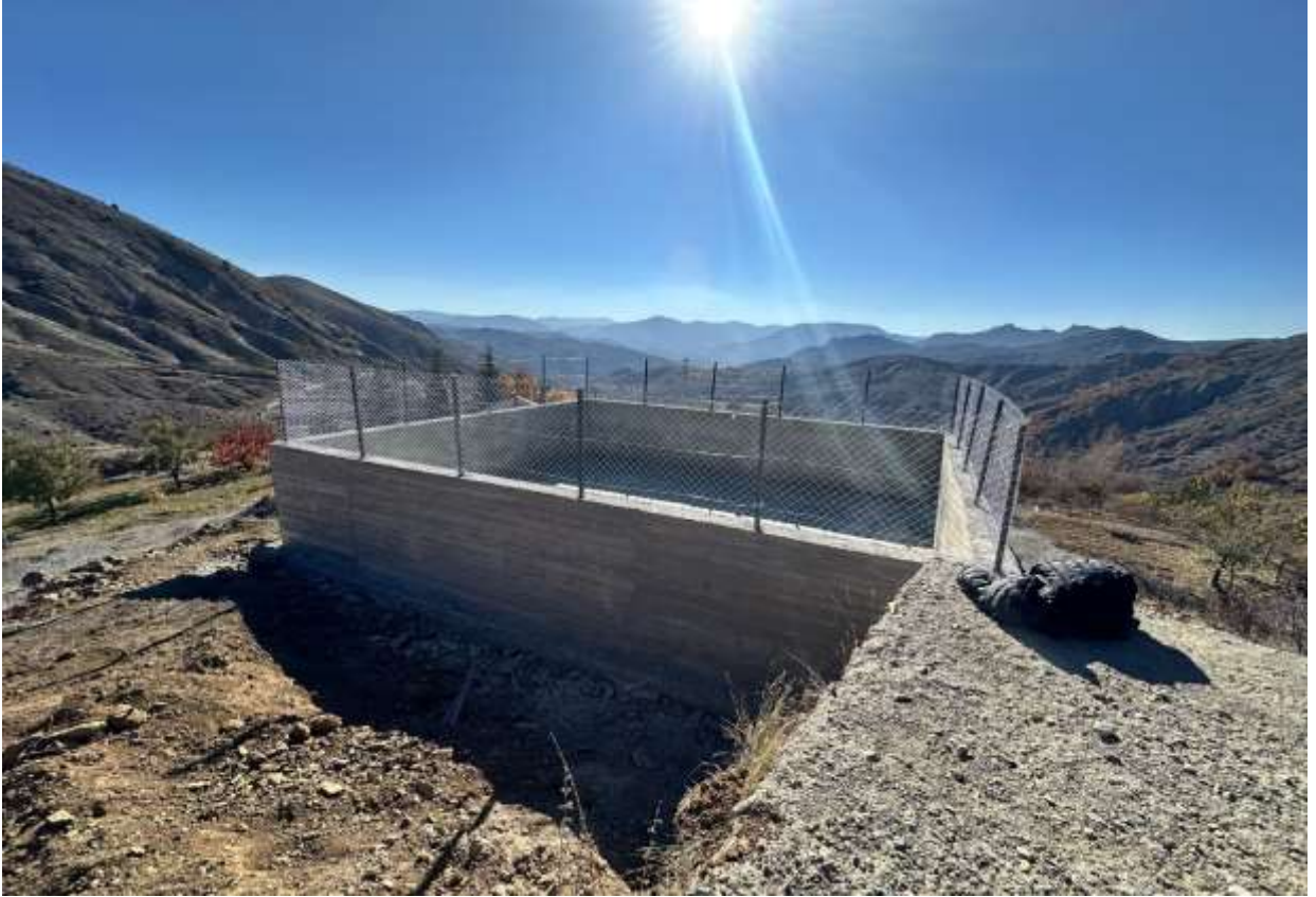
Merkez Yitirmez Köyü Sulama Tesisi (Köydes)
