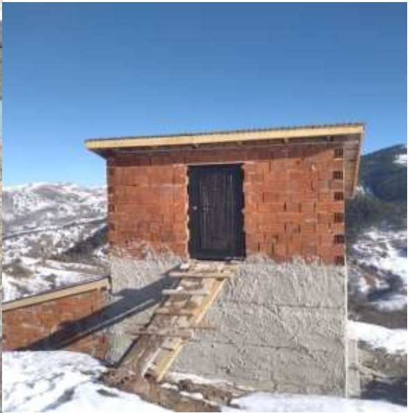
Merkez Sungurbeyli Su Deposu İşi
