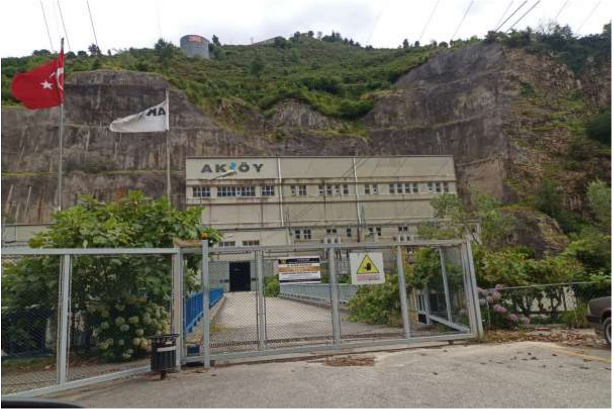
Kürtün-Üçtaş Köyü-Hidroelektrik Santral
