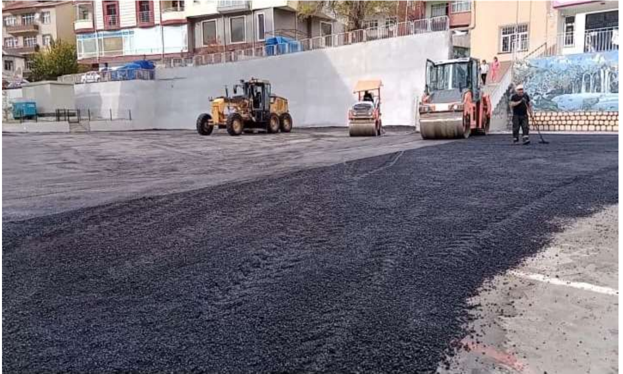
Aysin Rafet Ataç Okulu Bahçesinde BSK Asfalt Çalışması
