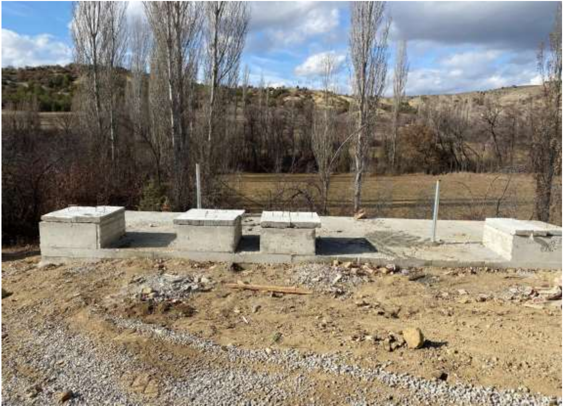
Şiran Çanakçı Köyü 250 Kişilik Foseptik Yapım Çalışmaları
