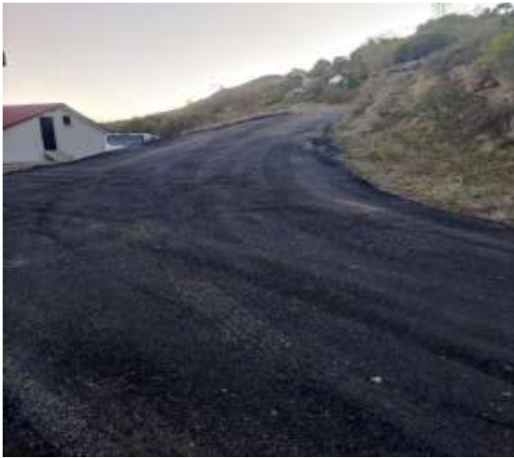
Kürtün Elmalı Köyü Asfalt Bakım Onarım Çalışması
