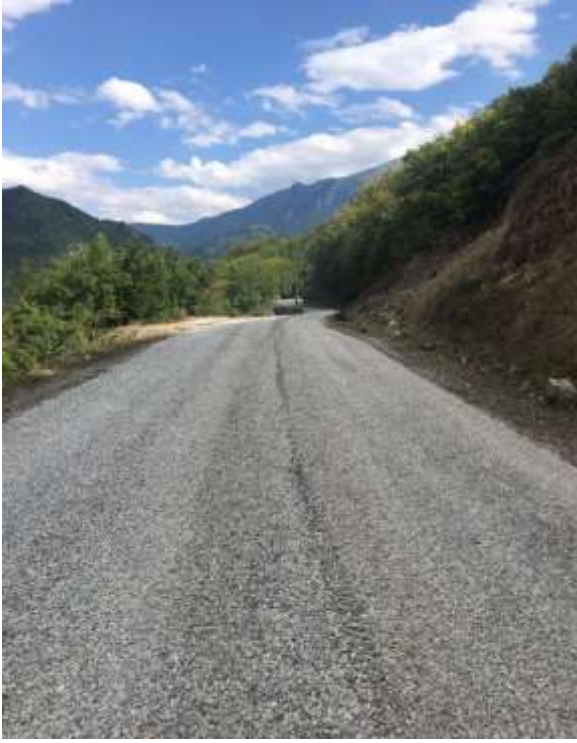
Şiran Çal Köyü Köy Yolu Asfalt Çalışması
