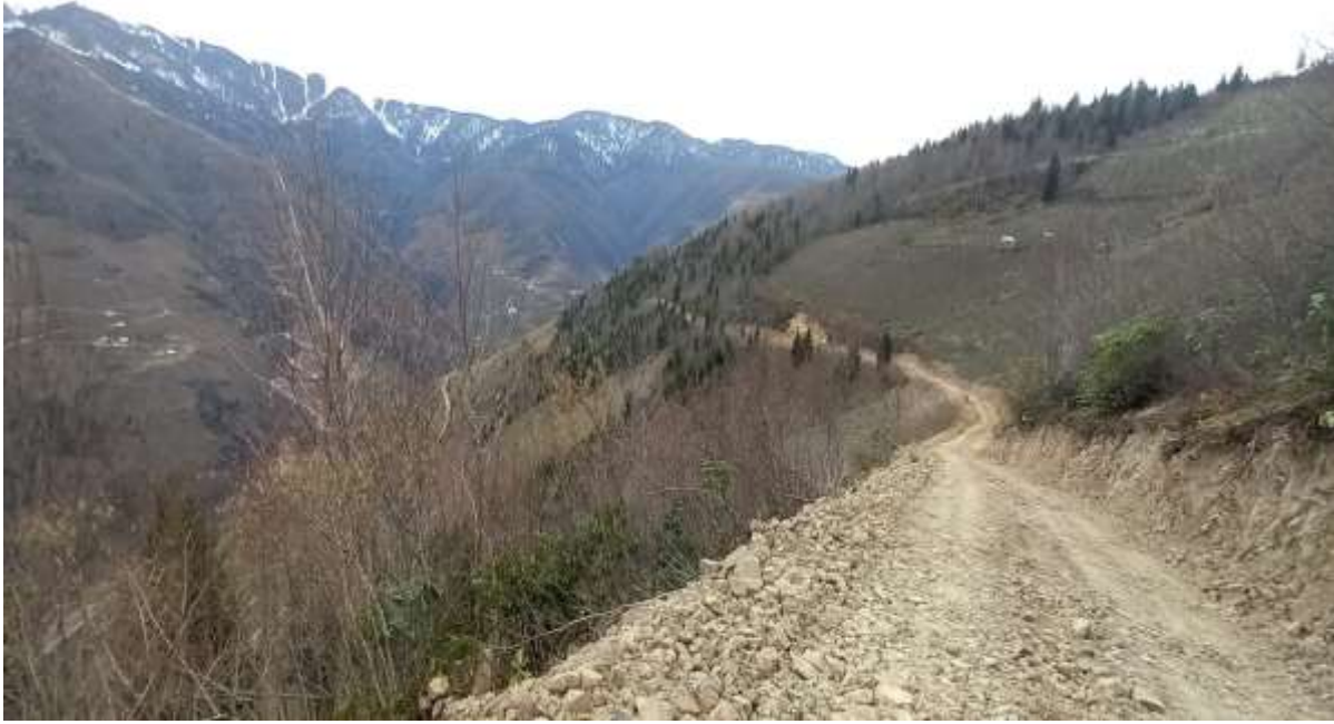
Kürtün Günyüzü Köyü Yol Yapım İşİ
