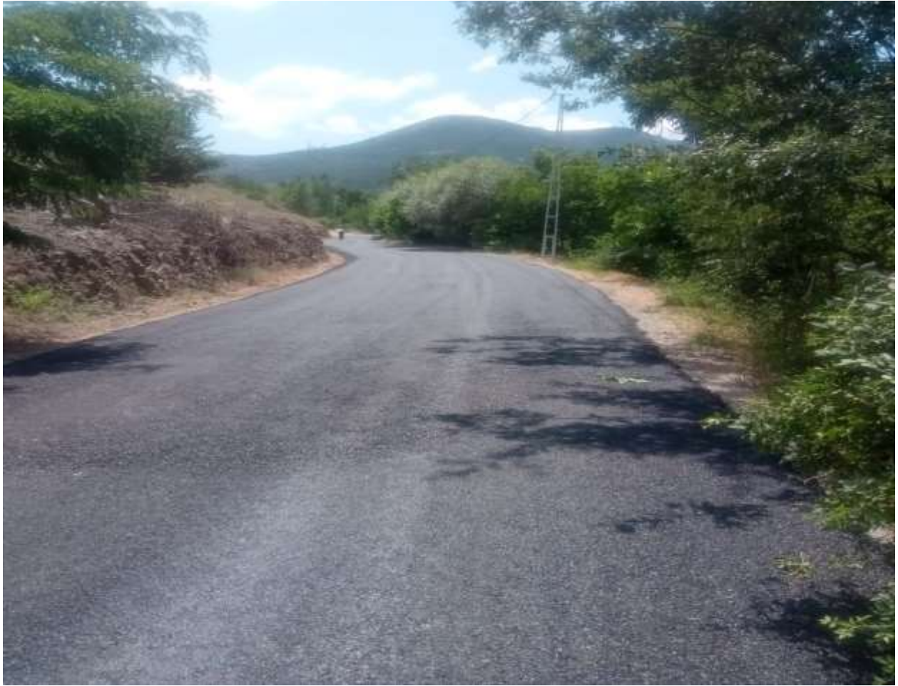
Şiran Selimiye Asfalt Bakım Onarım Çalışması
