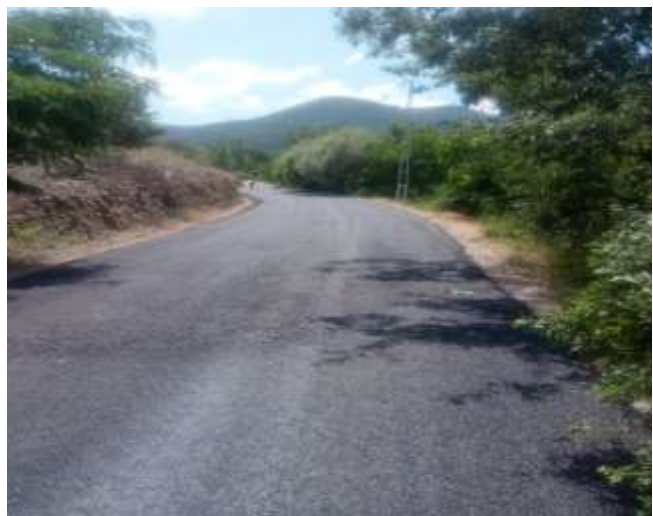
Şiran Selimiye Köyü Asfalt Bakım Onarım Çalışması
