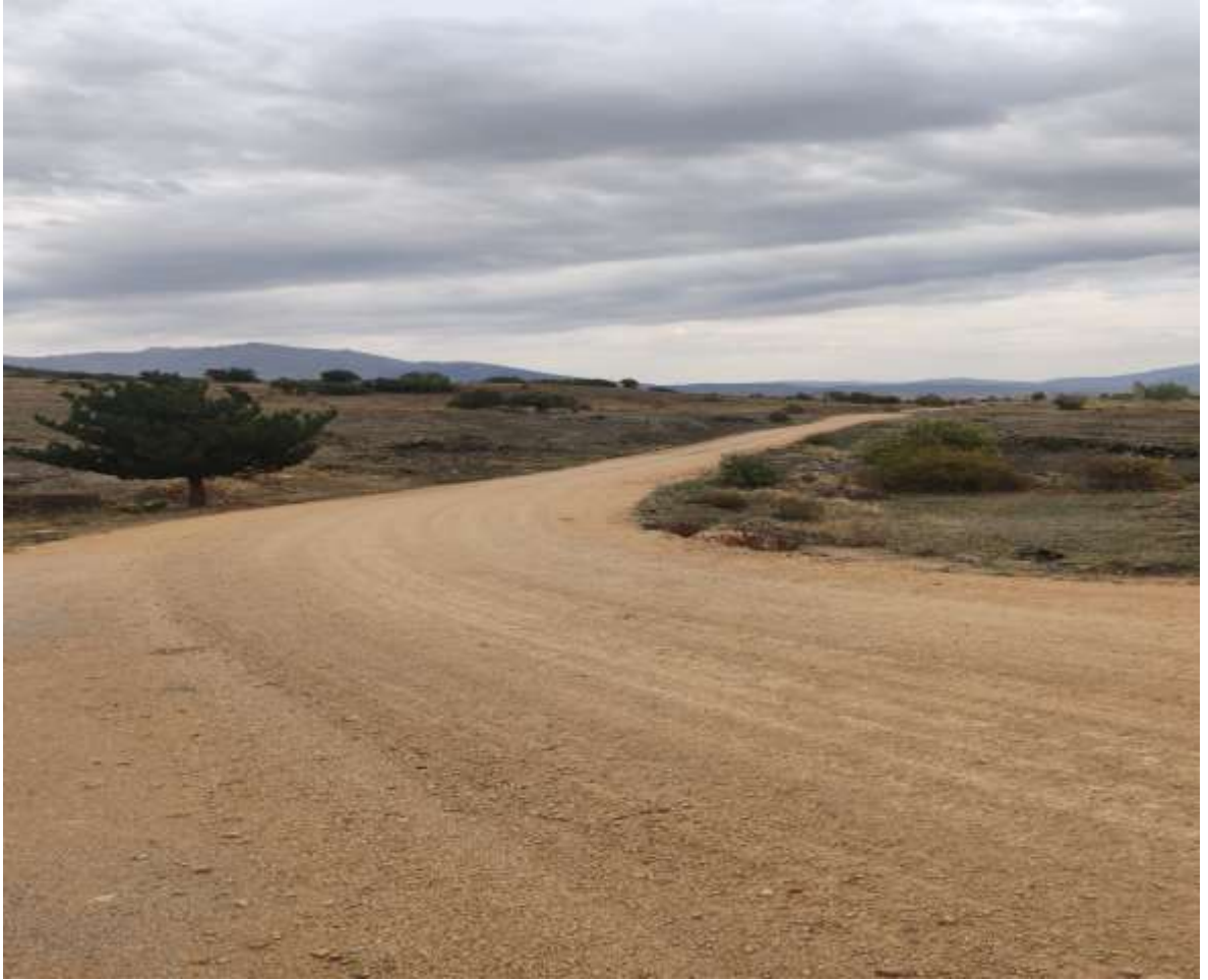
Şiran Selimiye Köyü Stabilize Çalışması
