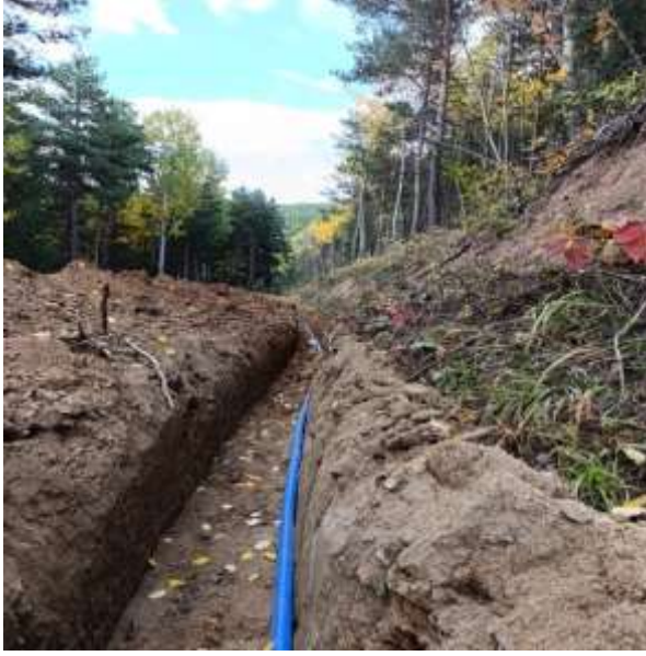
Şiran Çambaşı İçme Suyu İnşaatı
