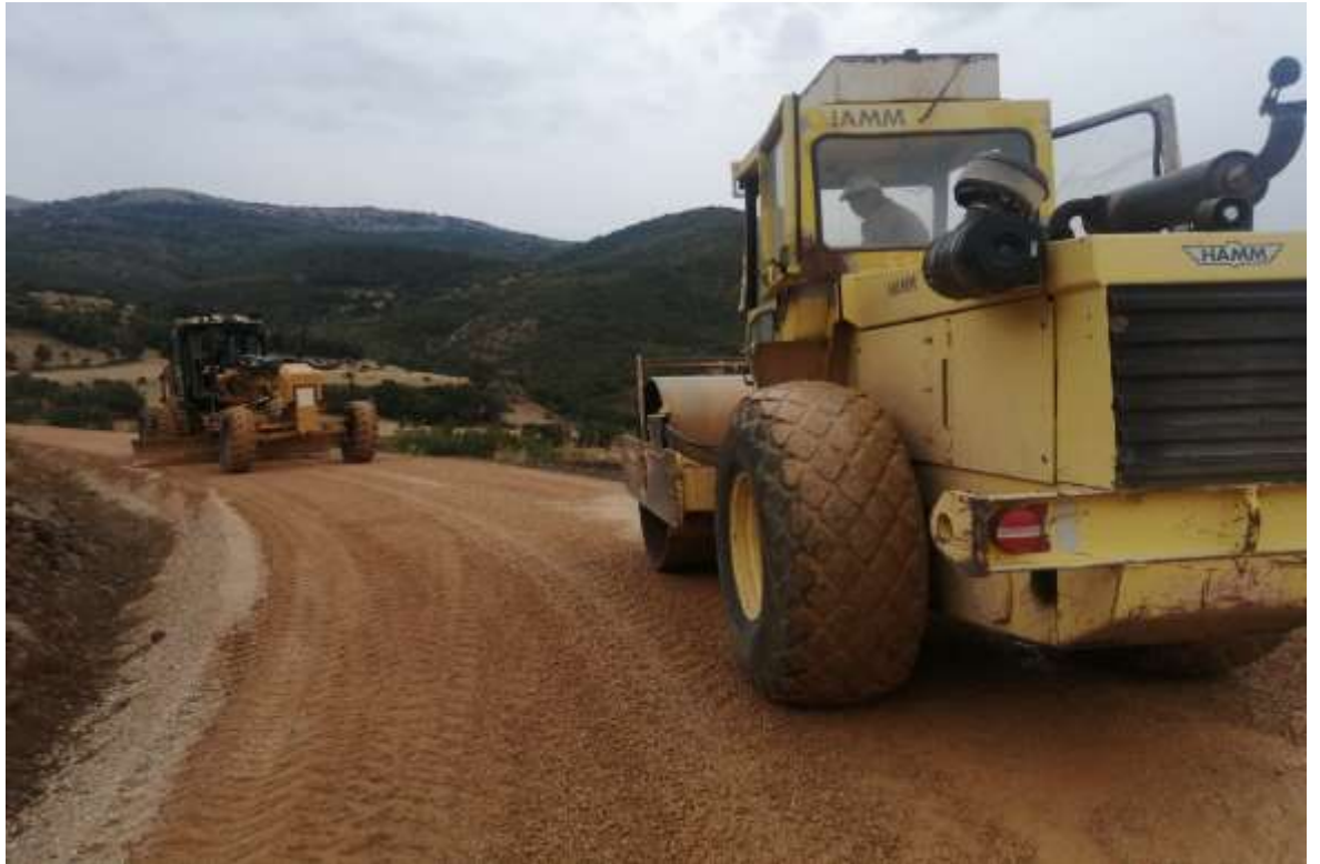
Şiran Başköy Mahalle Yolu Stabilize Yapımı
