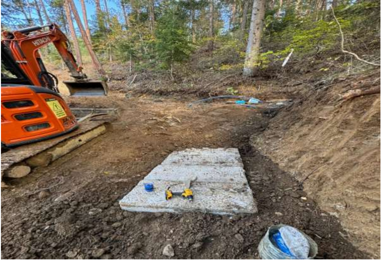
Yıldız Köyü Kaptaj Yapımı
