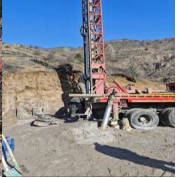
Merkez Çamlıköy Sondaj İşi
