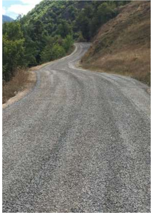
Torul Alinyayla Köyü Köy Yolu Asfalt Çalışması
