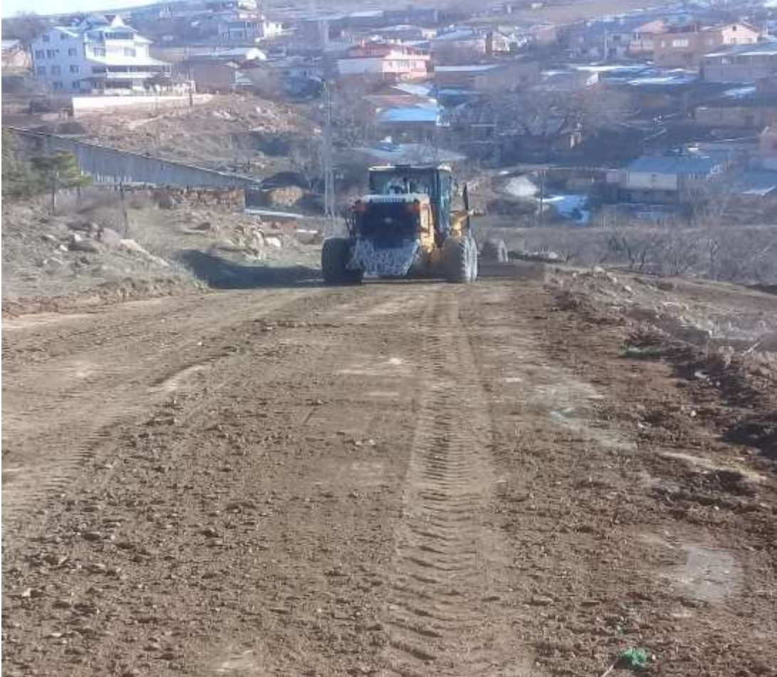
Şiran Bolluk Köyü Bağlantı Yolu Greyderle Reglaj Çalışması
