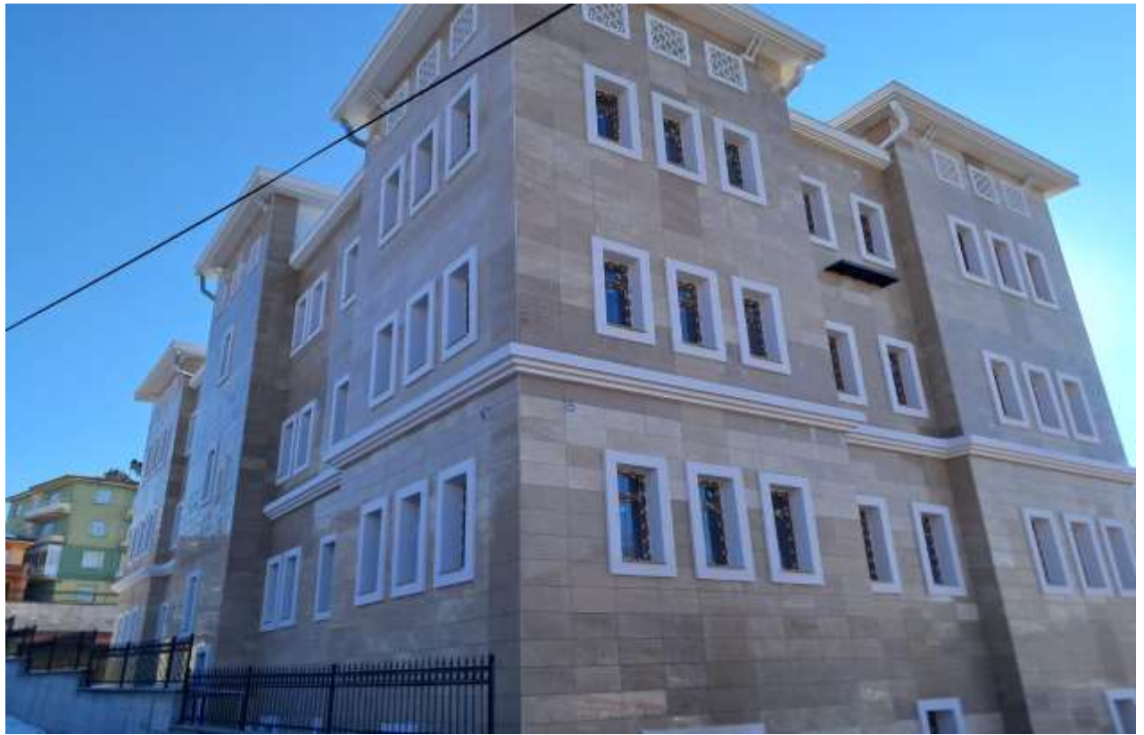
Köse Hükümet Konağı Yapım Çalışmaları
