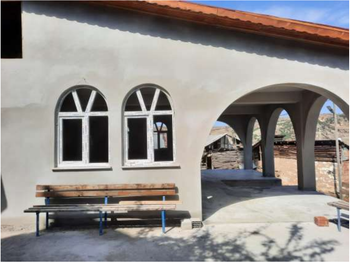
Süle Köyü Camii Sosyal Tesisi Yapım İşi Çalışmaları
