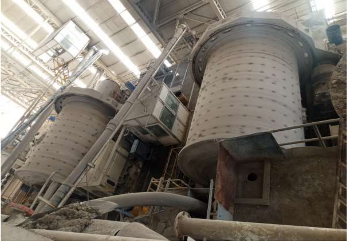
Merkez Karamustafa Köyü Altın-Kurşun-Çinko-Bakır Zenginleştirme Tesisi
