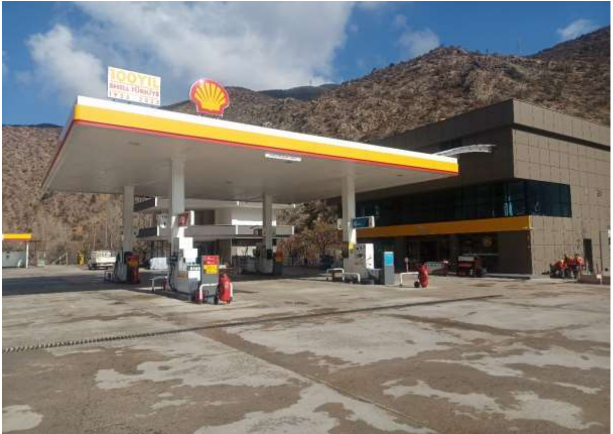
Torul-Harmancık- Köyü-Akaryakıt ve LPG İstasyonu
