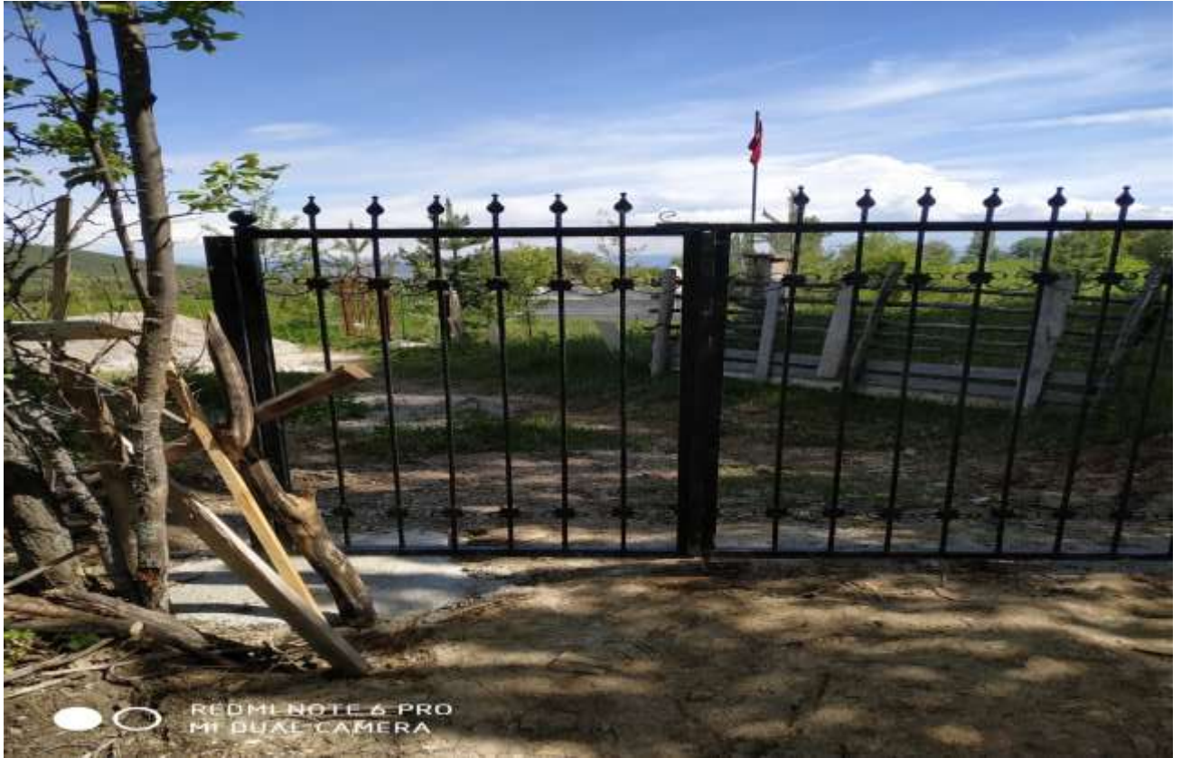
Şehit Yunus Emre Aygün'ün Mezarlık Giriş Kapısının Yapımı (Akbulak Köyü- ŞİRAN)
