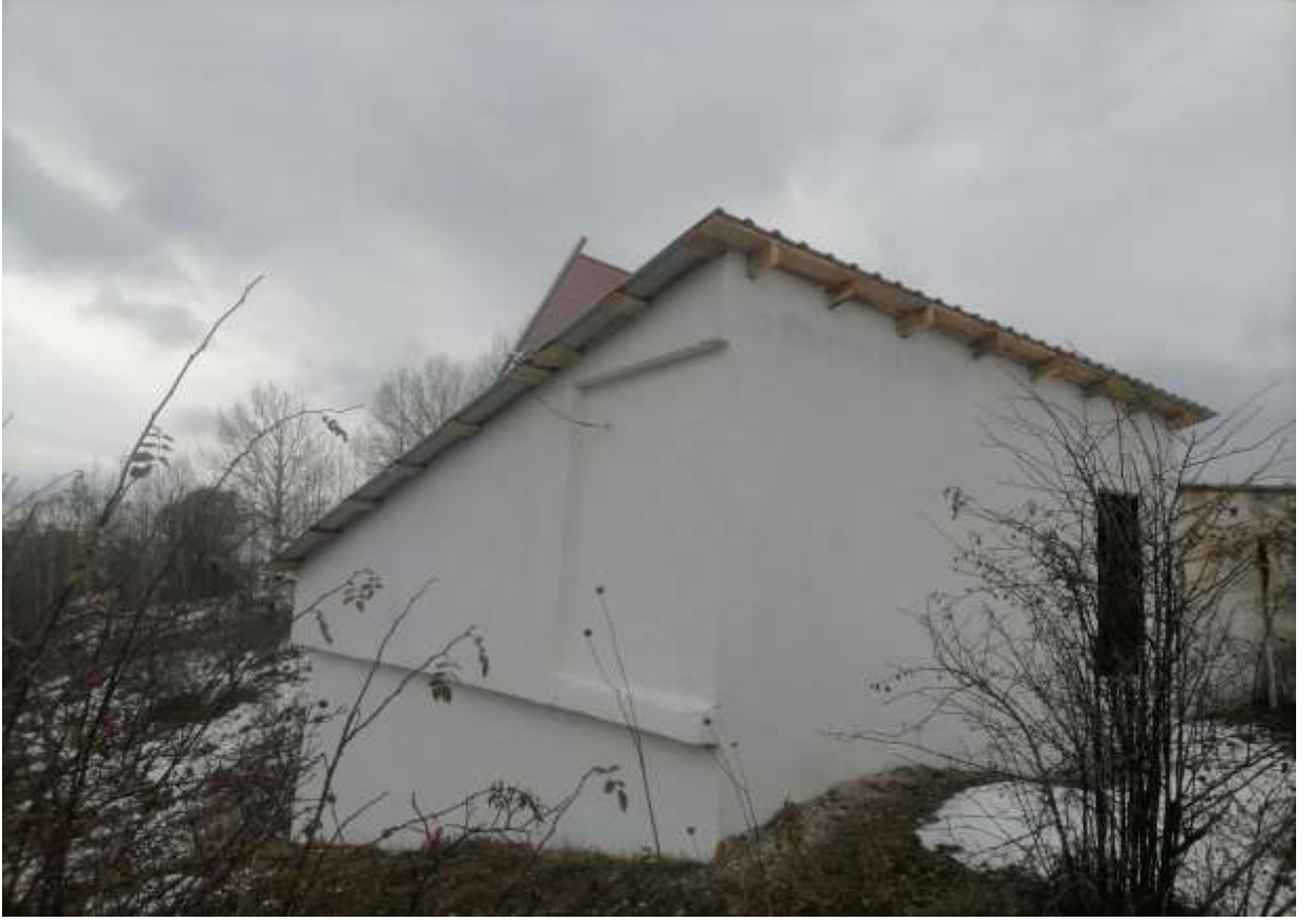
Uğurtaş Depo Onarımı
