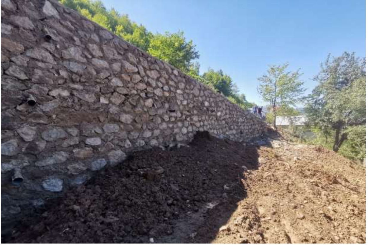
Kürtün Konacık Köyü Taş Duvar Yapım İşi
