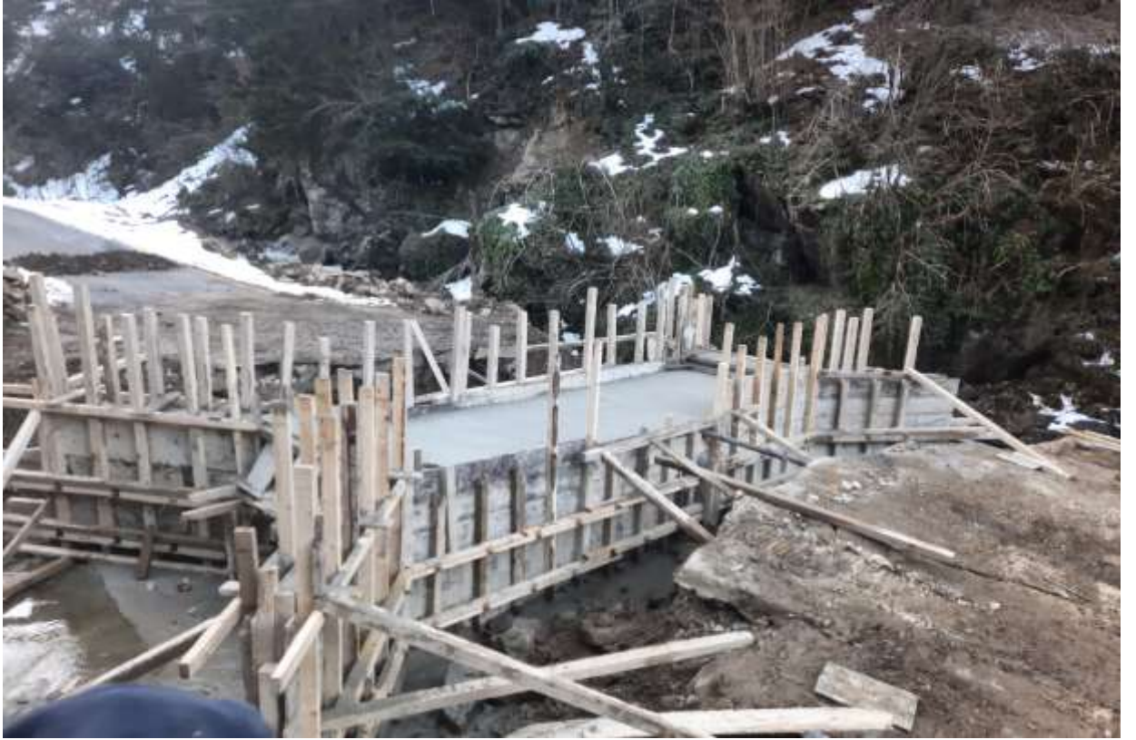
Merkez Dumanlı Köyü Menfez Yapım İşi
