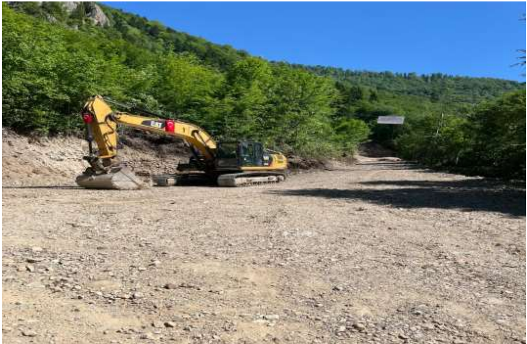
Kürtün Taşlıca Mahalle Yolu Onarım Çalışması
