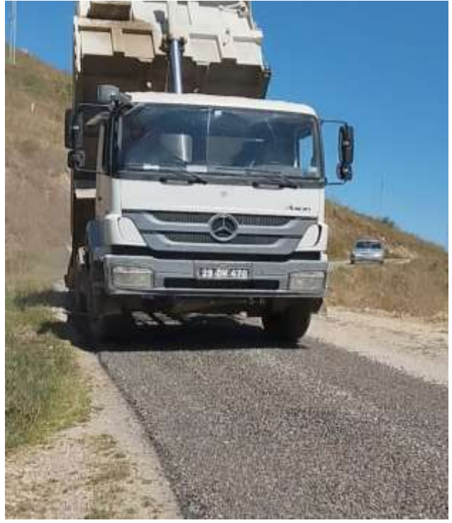
Kürtün Yaylalı Köyü Köy Yolu Asfalt Çalışması
