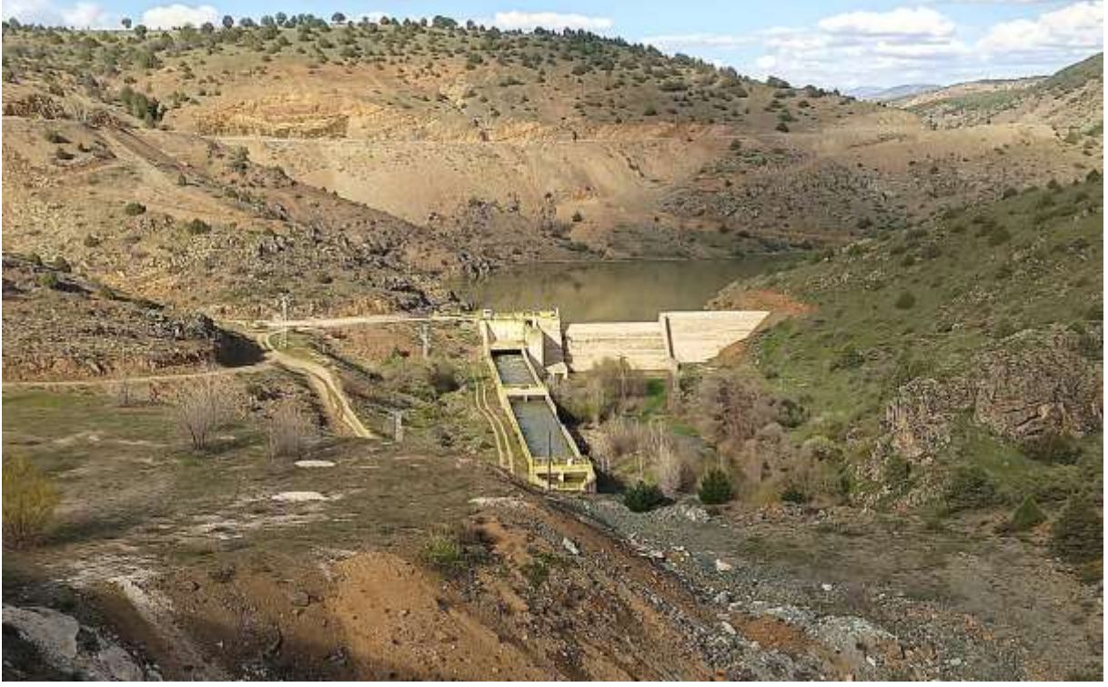
Şiran-Sadık Köyü- Hidroelektrik Santrali
