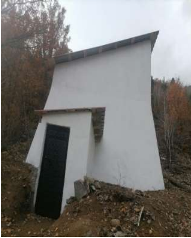
Atalar Köyü Depo Yapımı
