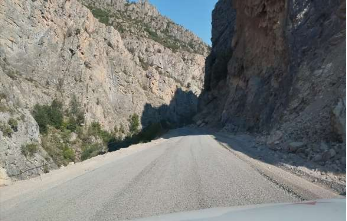
Merkez Yağlıdere Grup Yolu Asfalt Çalışması
