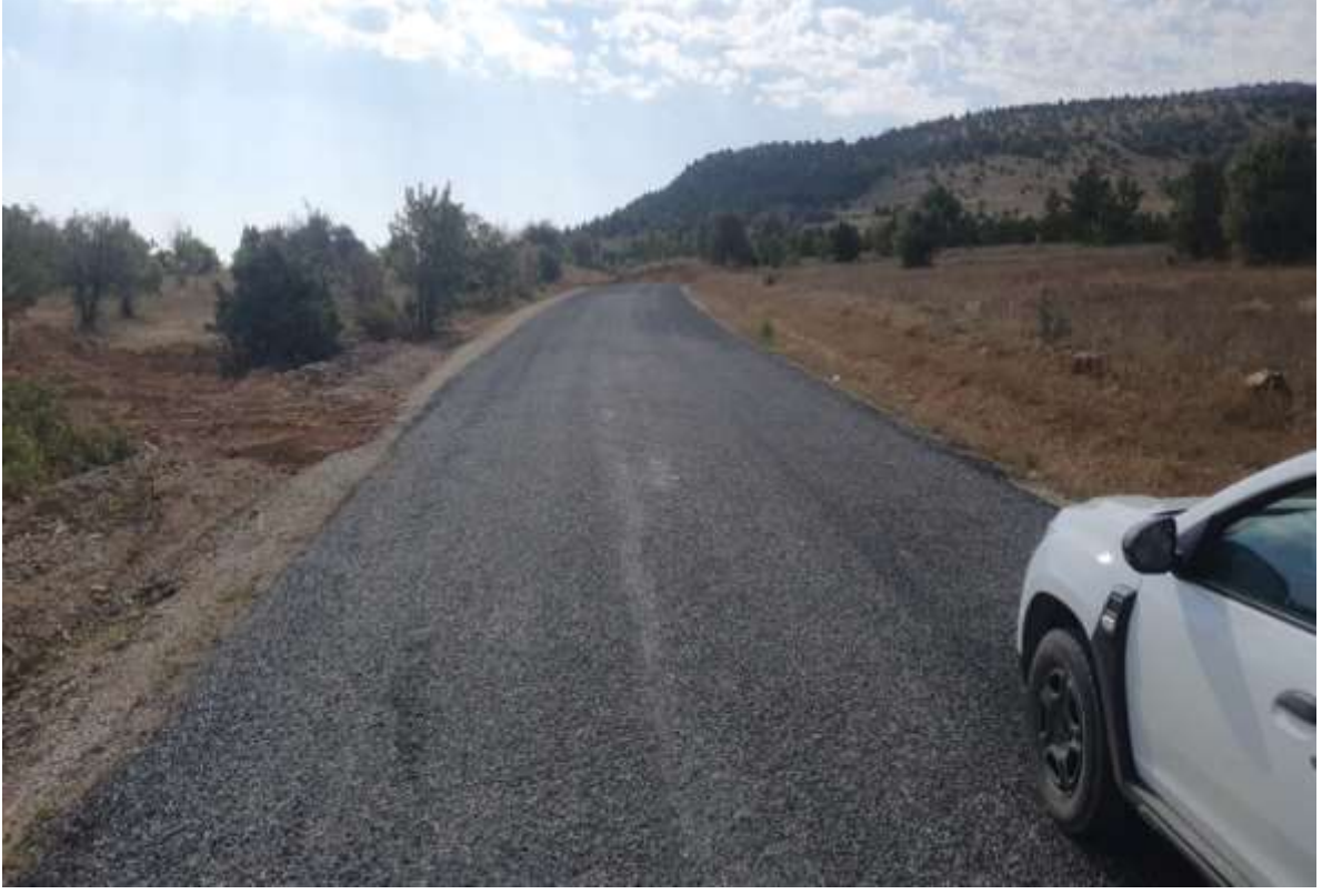
Şiran Yukarıkulaca Köyü Asfalt Çalışması
