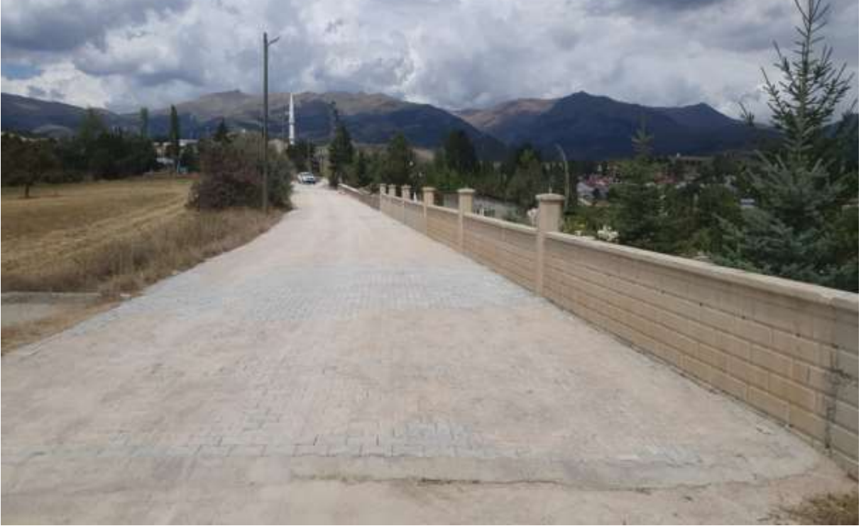
Şiran Bahçeli Köyü Parke Yapım İşi
