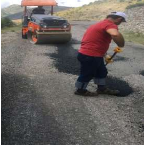
Asfalt Yama Çalışması
